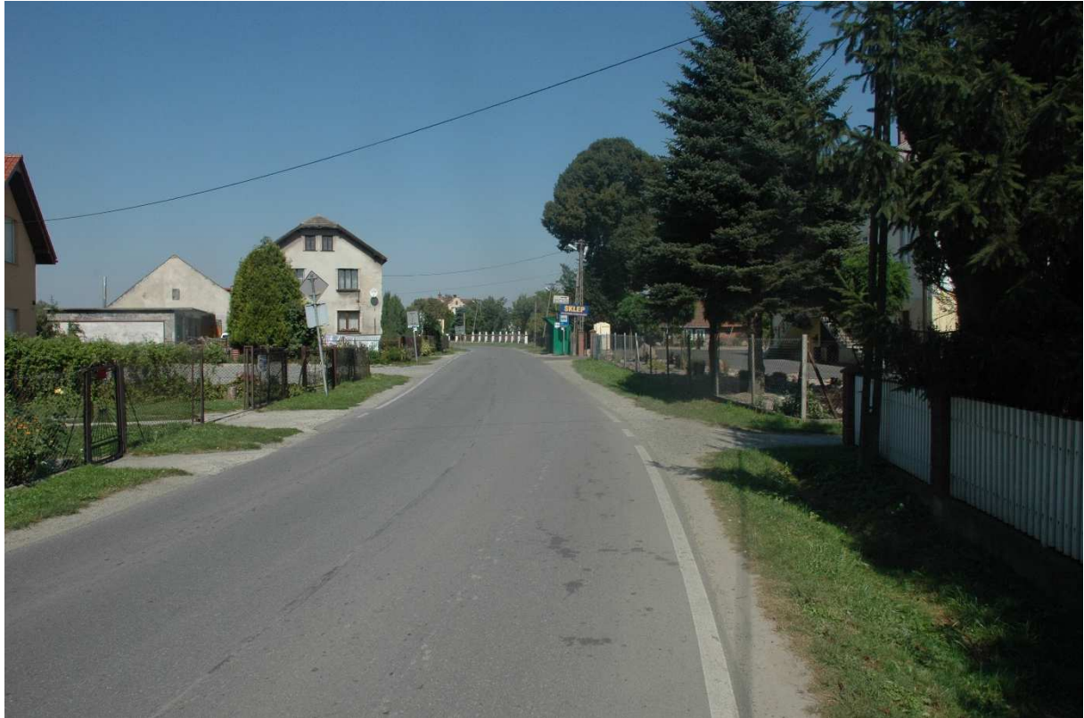
Fot. 3 Widok stanu istniejącego km 5+060,00
