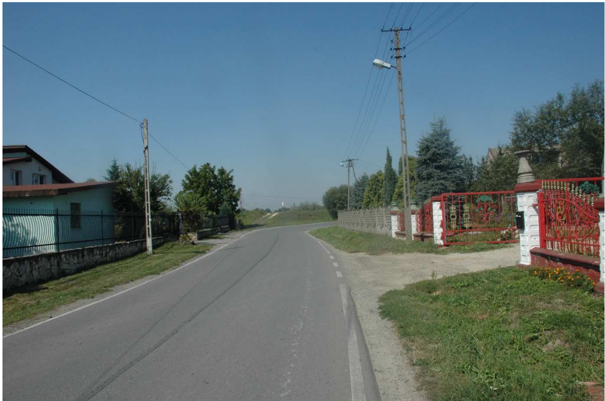
Fot. 4 Widok stanu istniejącego km 5+200,00
