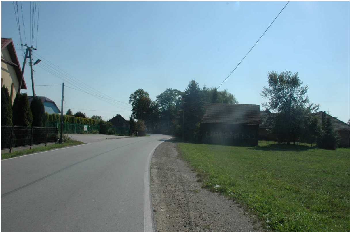
Fot. 8 Widok stanu istniejącego km 5+800,00
