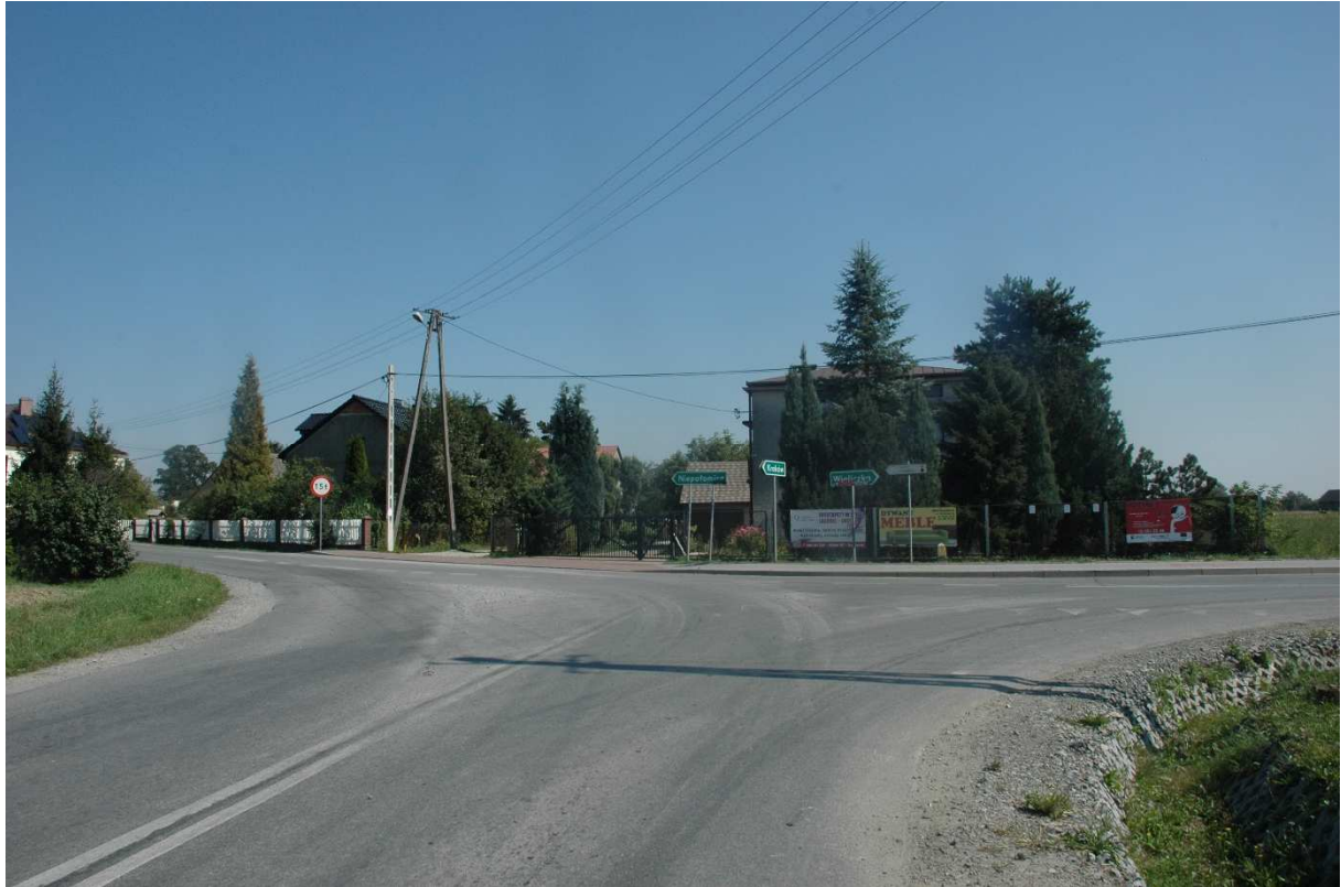
Fot. 1 Skrzyżowanie z drogą powiatową nr 2012 K km 4+957,50, koniec opracowania odcinka nr 1 oraz początek opracowania odcinka nr 2
