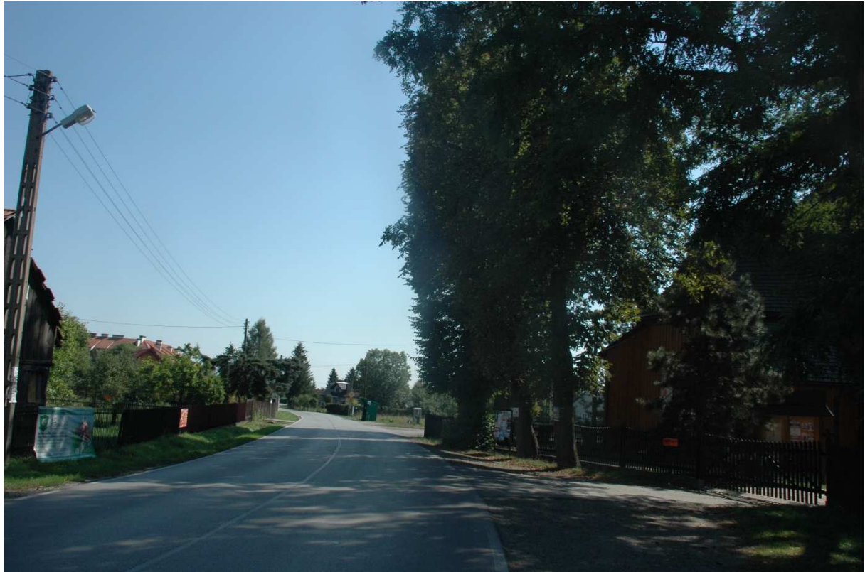
Fot. 9 Zjazd do kościoła km 5+900,00
