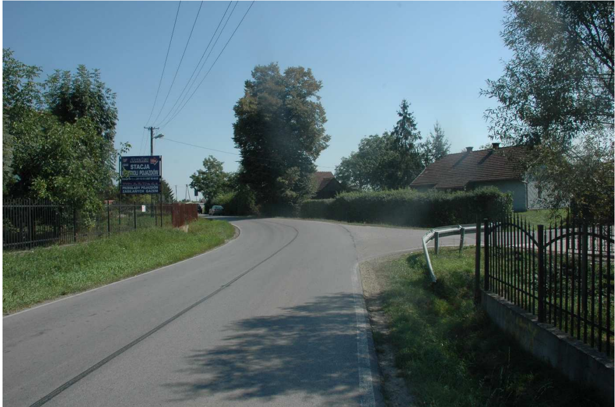
Fot. 13 Skrzyżowanie z drogą gminną nr 560936 K km 6+126,50
