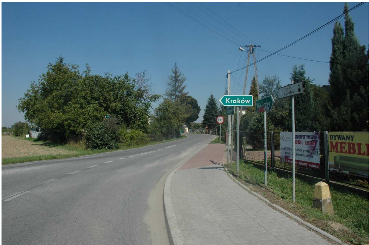
Fot. 2 Istniejący chodnik prawostronny km 4+964,10
