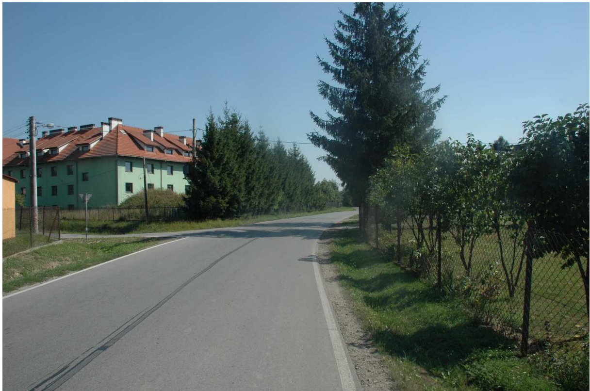
Fot. 12 Skrzyżowanie z drogą gminną nr 560937 K km 6+041,70
