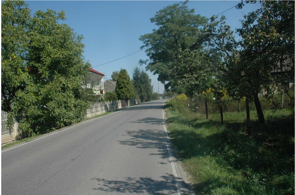
Fot. 5 Widok stanu istniejącego km 5+450,00
