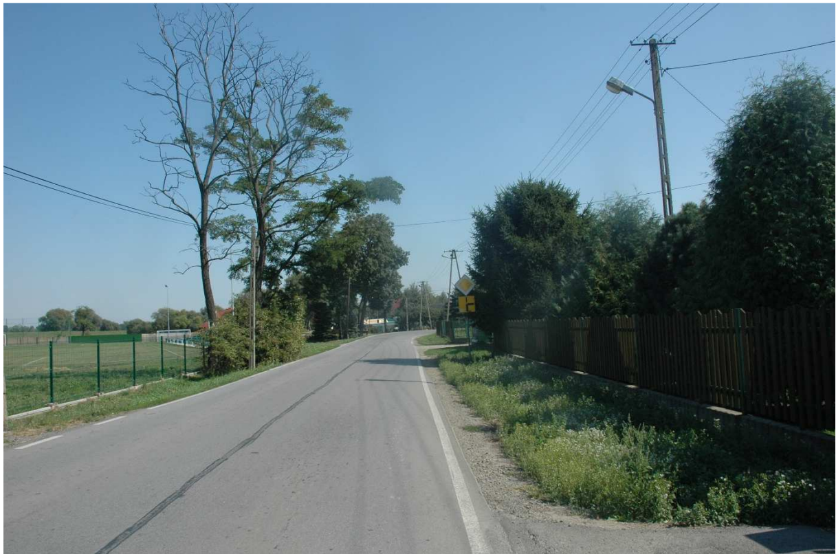
Fot. 6 Widok stanu istniejącego km 5+580,00
