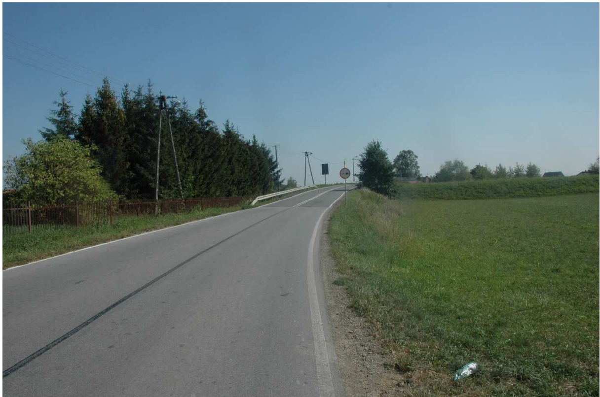
Fot. 14 Widok stanu istniejącego km 6+210,00
